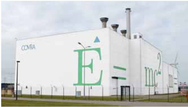
ABBILDUNG 1: Langfristiges Zwischenlager HABOG in den Niederlanden. Im Rahmen der Instandhaltungsmaßnahmen wird die Farbe der Gebäudehülle wie angedeutet verändert werden, um die Verringerung der vom radioaktiven Abfall emittierten Wärme anzuzeigen.
